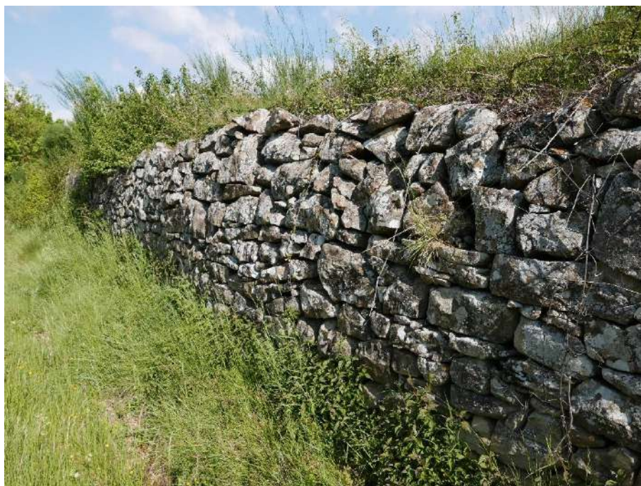
Muret de pierres sèches
